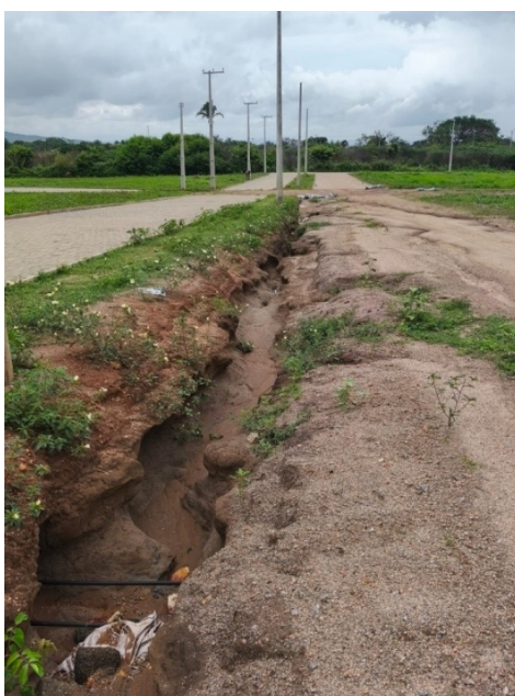
Figura 01: Ravina formada em terrenos na baixa encosta da Chapada do Araripe
