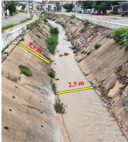
Figura 2: Medidas do Canal do Rio Granjeiro
