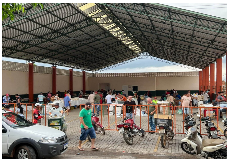
Figura 3: Galpão dos feirantes de Mucambo (CE).
