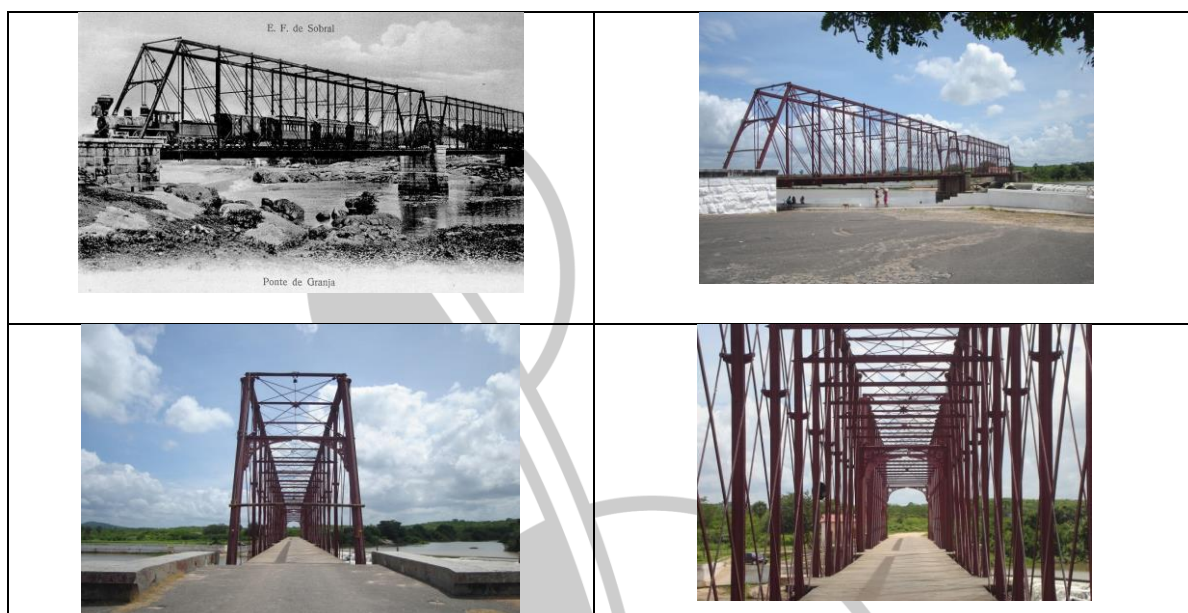
Figura 1: Quadro de fotos da ponte metálica de Granja –CE
