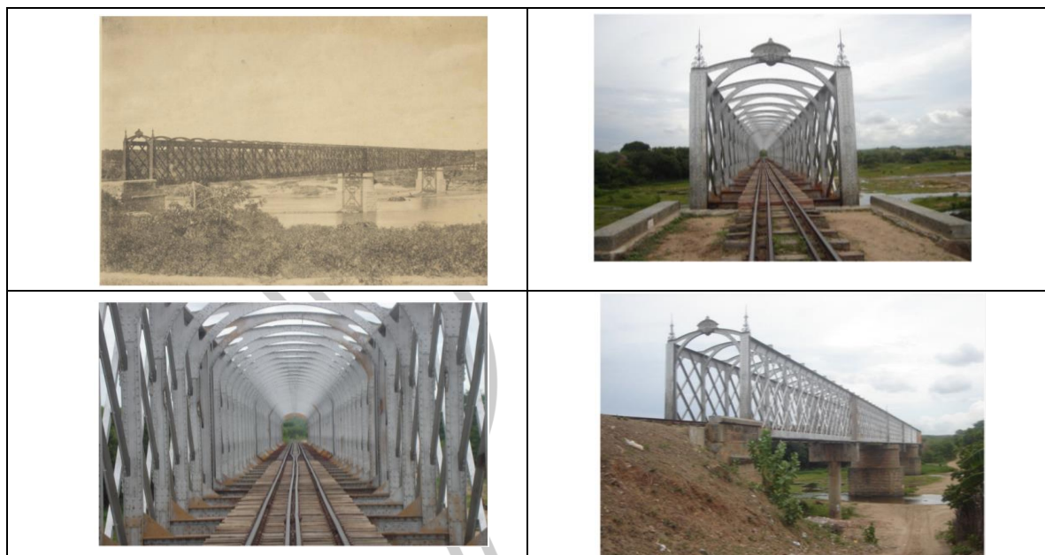
Figura 5: Quadro de fotos da ponte metálica de Senador Pompeu –CE. Inventário do IPHAN, 2008
