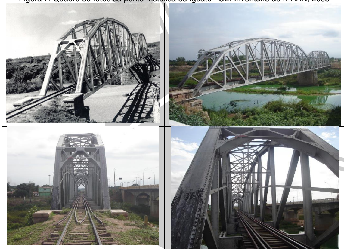
Figura 7: Quadro de fotos da ponte metálica de Iguatu –CE. Inventário do IPHAN, 2008
