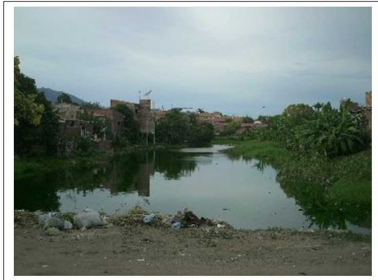
Fotografia 4: A Barragem do Bairro completamente poluída em decorrência das redes de afastamento Fonte: MORAIS, R. S., 2008
