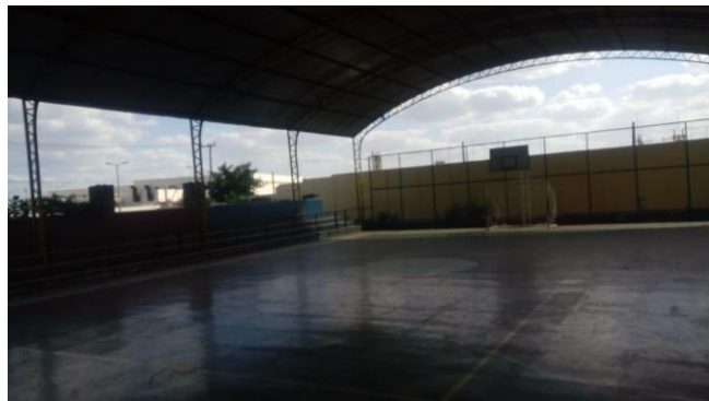
Figura 1: Quadra poliesportiva coberta
