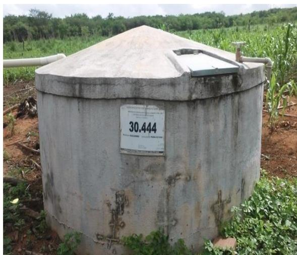
FIGURA 4. Cisterna de placa na localidade de Pedra de Fogo – Mucambo – CE.
