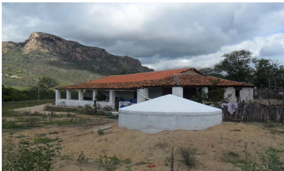
Figura 1. (Cisterna de placa, Faz. Exu, Taperuaba, Sobral-CE)
