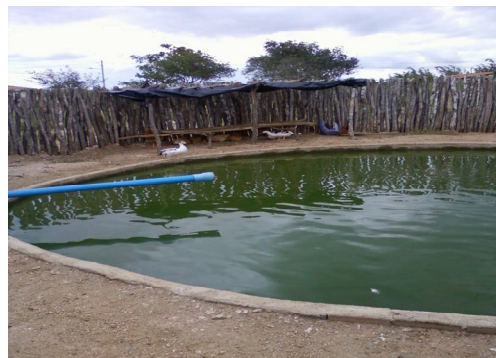
Foto 3. Tanque para irrigação
