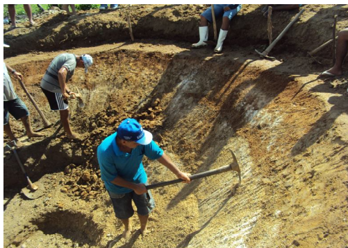
Foto 2. Escavação do tanque de irrigação
